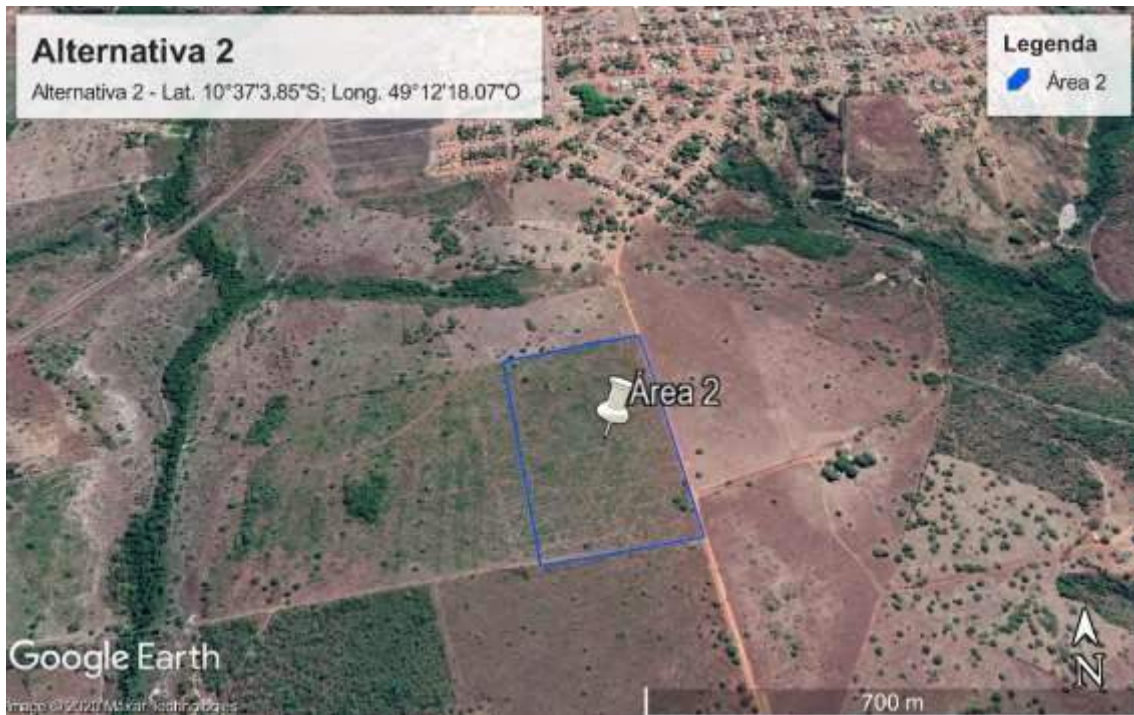
Figura 23: Alternativa 2 de área para implantação de Aterro Sanitário em Cristalândia - TO Fonte: VRP Ambiental, 2020
