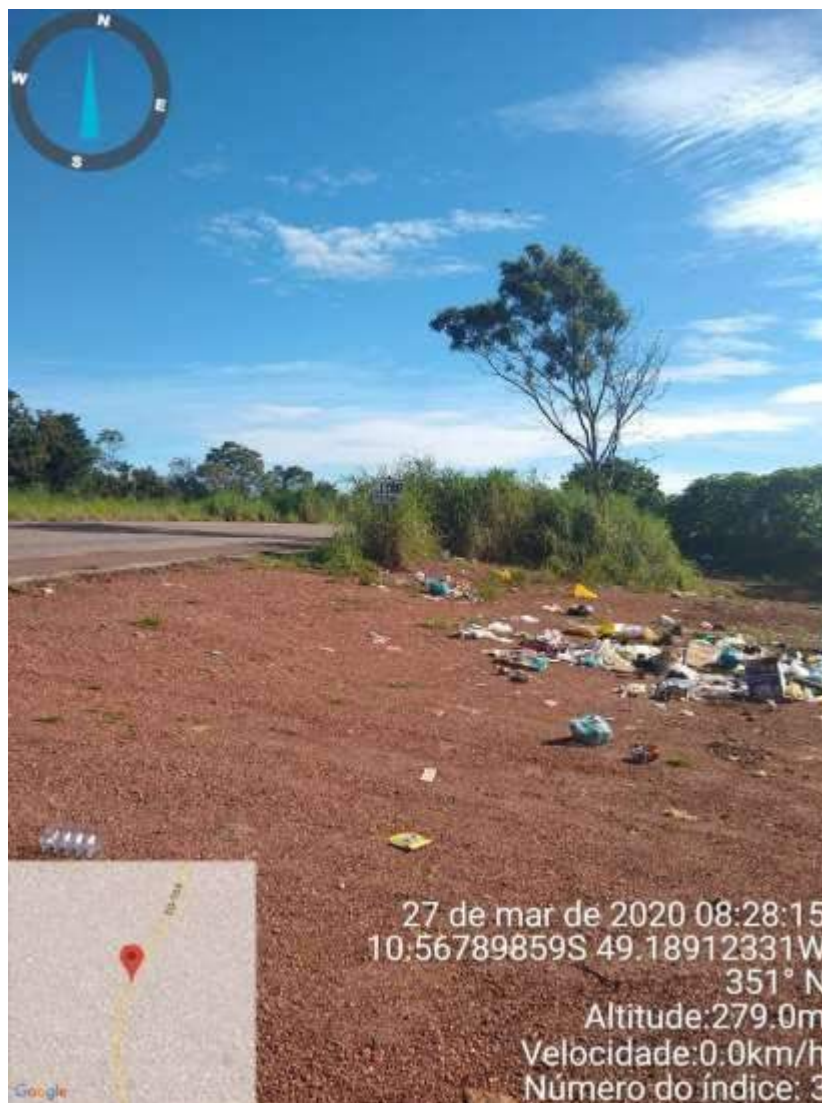
Figura 16: Entrada à área de disposição dos resíduos sólidos urbanos de Cristalândia - TO, sem controle de acesso
