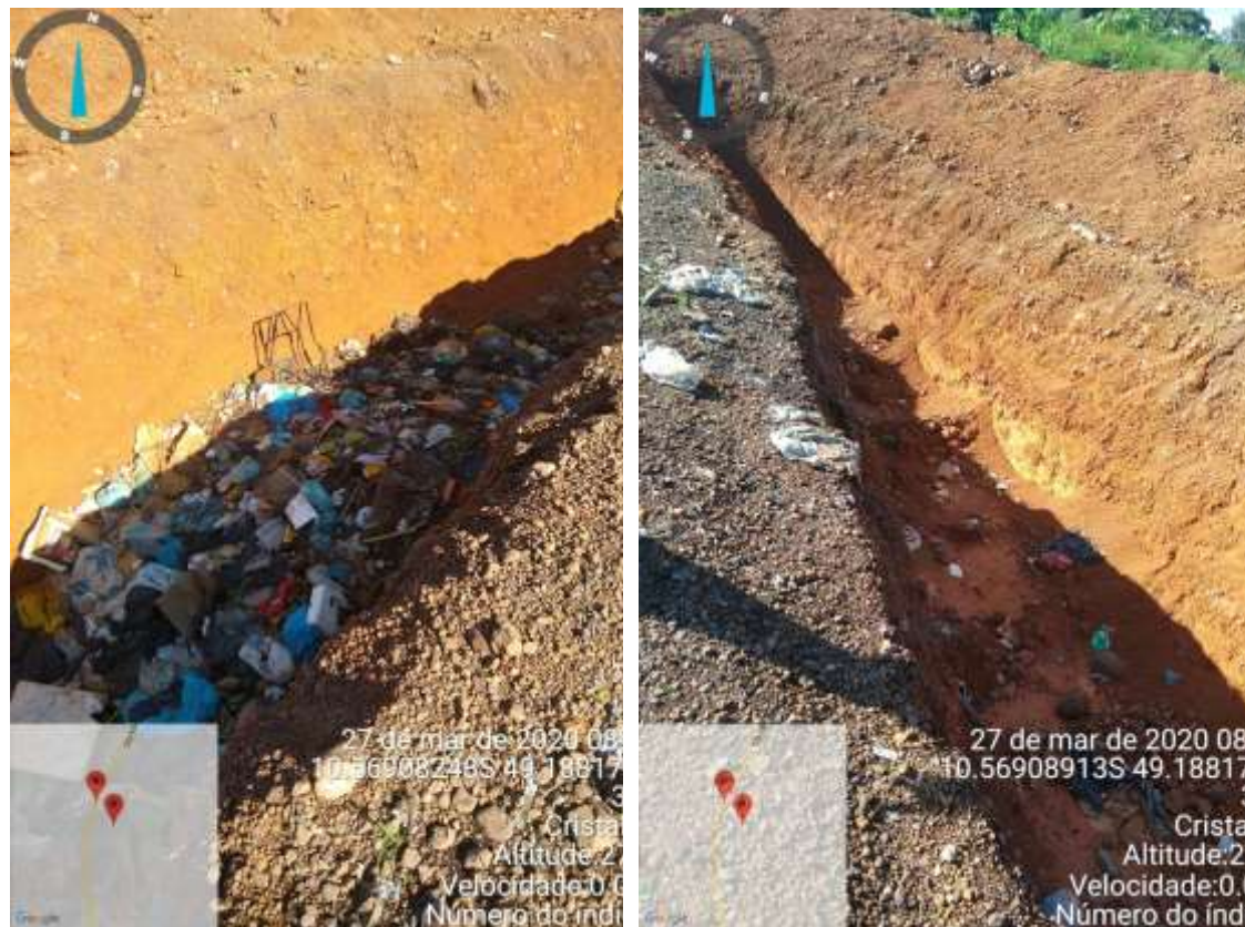
Figura 17: Valas abertas para recebimento de resíduos sólidos Fonte: Prefeitura Municipal de Cristalândia – TO, 2020
