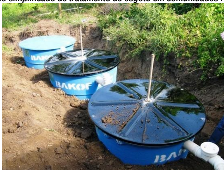
Figura 15. Modelo simplificado de tratamento de esgoto em comunidades rurais (EMBRAPA)
