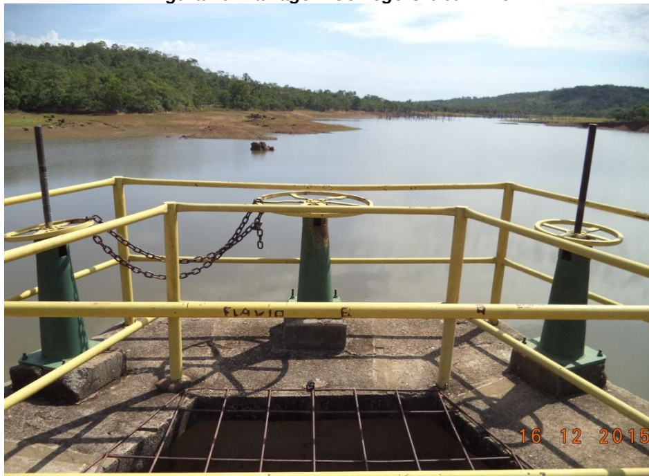
Figura 19. Barragem Córrego Urubuzinho
